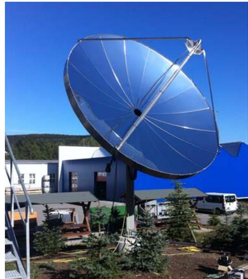
Am Standort der WätaS in Olbernhau erfolgen jetzt in Zusammenarbeit mit dem Institut für angewandte Energieeffizienz Tests zum Nachweis der Leistungsfähigkeit der Anlage zur Unterstützung der Erzeugung von warmem Brauchwasser für Fertigungs- und Heizprozesse. Damit wird das Ziel verfolgt, die Eignung für den deutschen Markt zu prüfen. Gleichzeitig werden die Voraussetzungen für eine mögliche Fertigung in Sachsen ermittelt, gegebenenfalls auch in einer Version mit ca. 4 kW Leistung.
