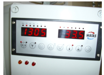
Elektronik Wärmepumpe links: Uhrzeit, rechts: Rücklauf Heizung
