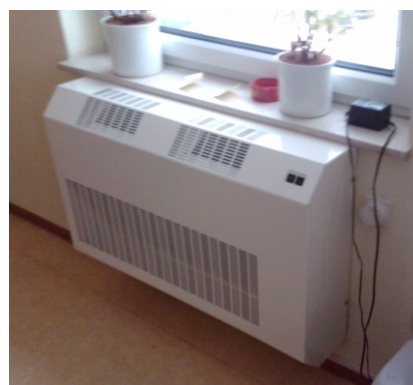
Aktive Nieder-Temperatur-Thermotruhen im Bürogebäude
