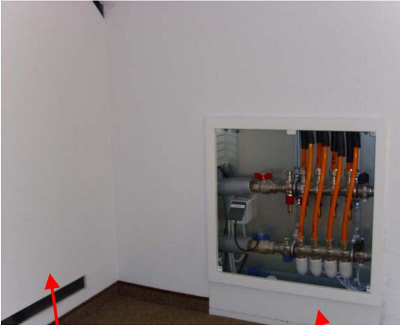
Ausschnitt einer Wandfläche incl. Verteilerschrank mit der Möglichkeit zum Heizen und Kühlen.
