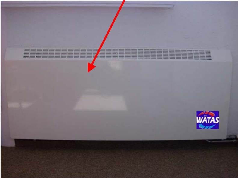
Heizleiste ist in dieser Ausführung als aktive Variante mit Lüfterunterstützung. Sie kann auch als passive Variante betrieben werden.
