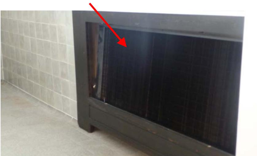
Wärmetauscher als passive Variante in einer Nische. Schräge Einbaulage zur Wand für eine bessere Luftzirkulation.
